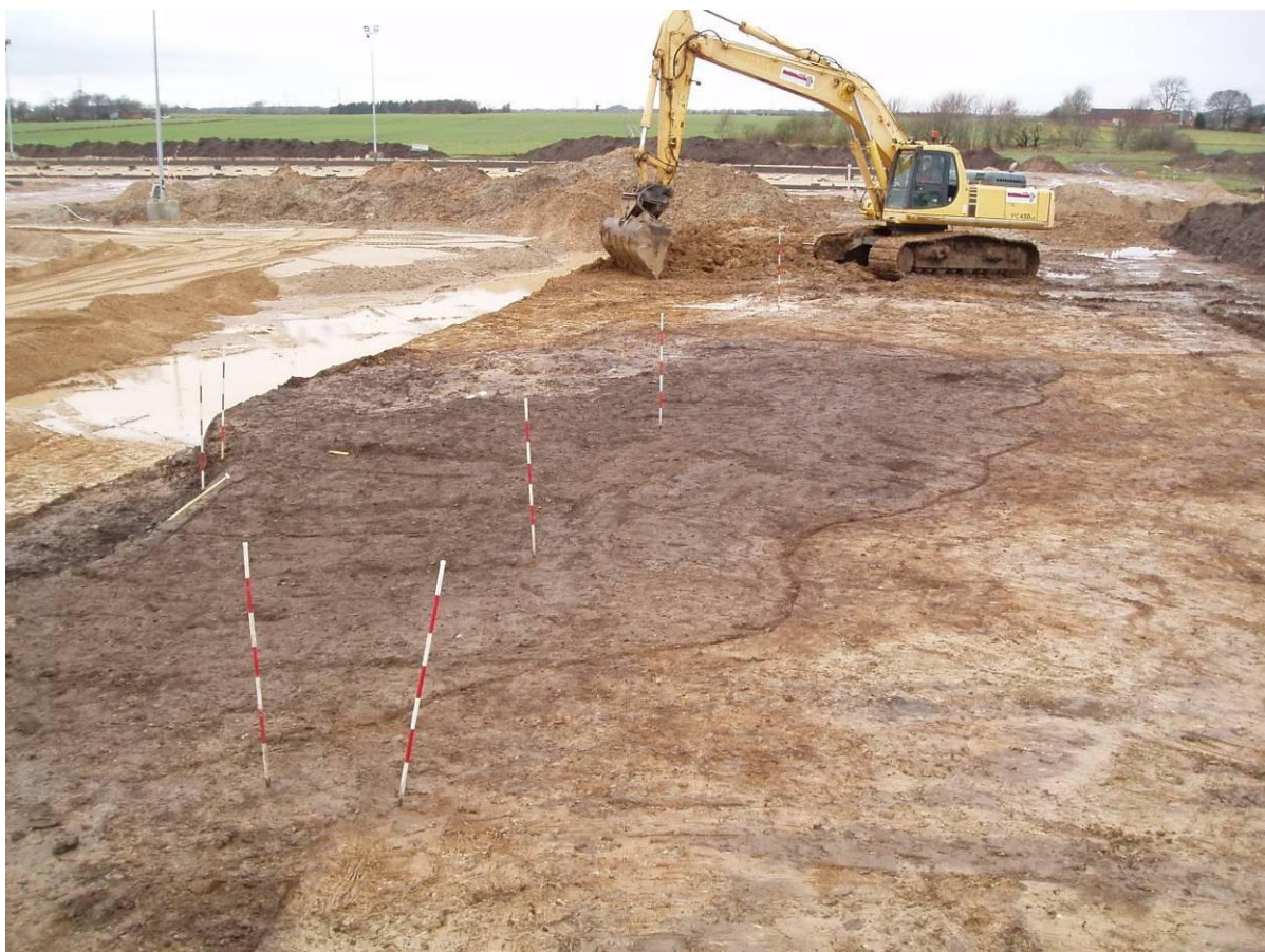
Figur 1: Arbejdsbillede af den store forsænkning der allerede delvist var bortgravet ved det påbegyndte anlægsarbejde. Billedet er taget efter, at den resterende del er muldafrømmet med maskine. I baggrunden ses gravemaskine fra entreprenør Martin Hansen, Mammen.
