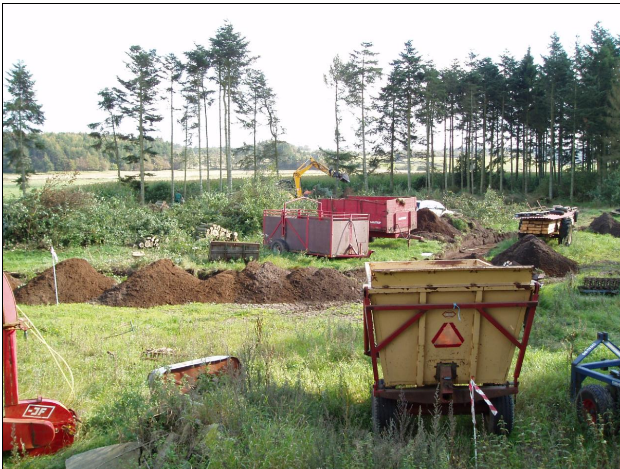
Figur 2: Prøvegravningen blev foretaget i al hast mellem maskiner og materialer, der lå opmagasineret på byggeområdet.
